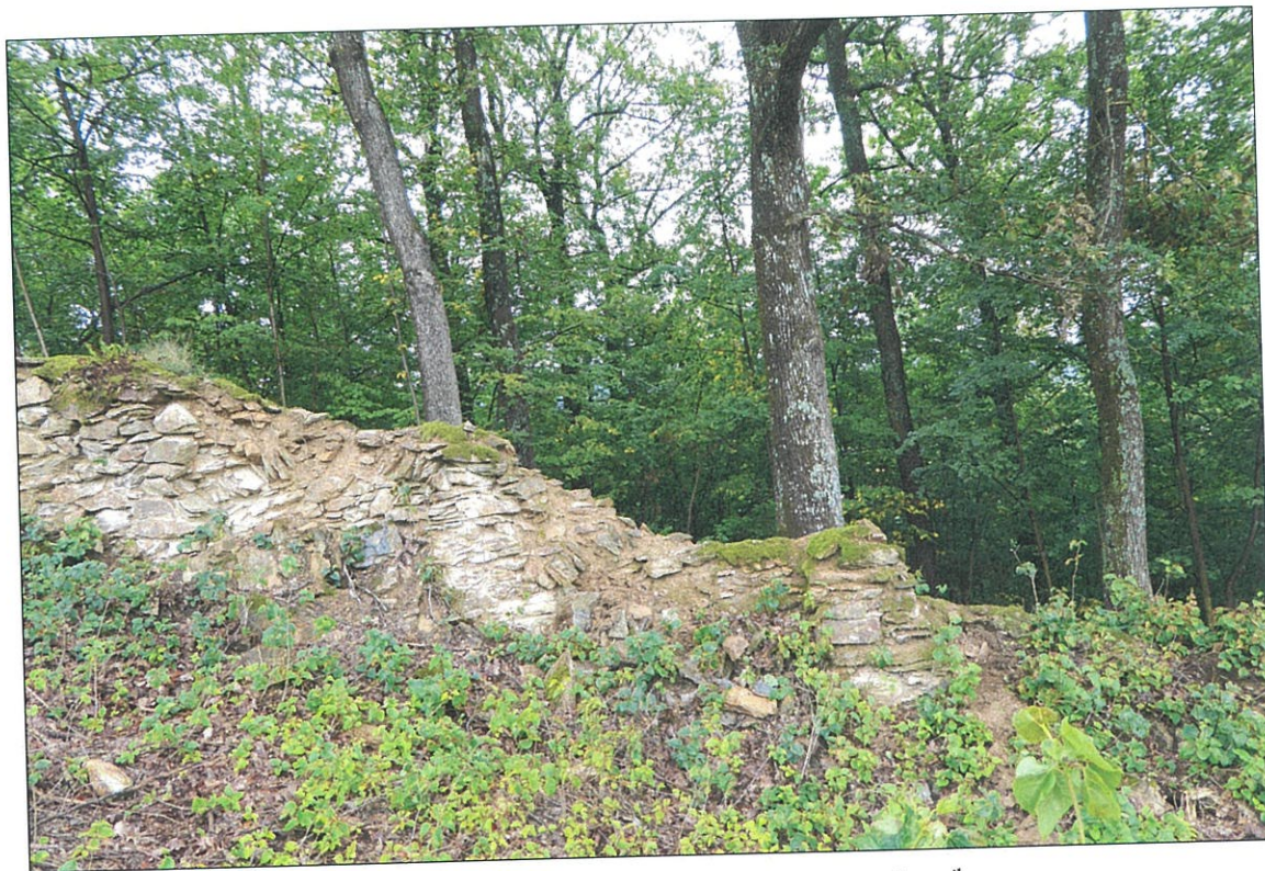
10. Ohradný múr na východnej strane s torzom trojice ník
