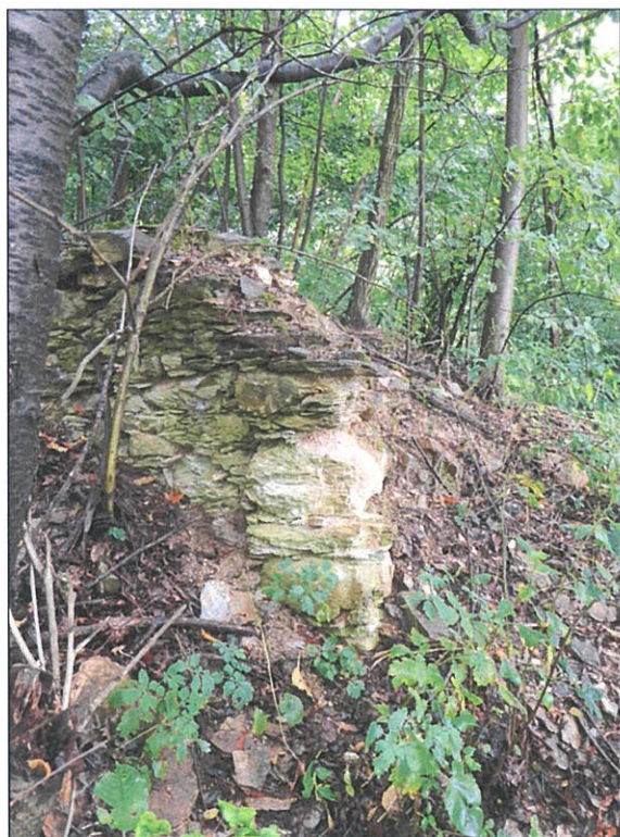
74. Torzo pôvodnej barokovej kaplnky
