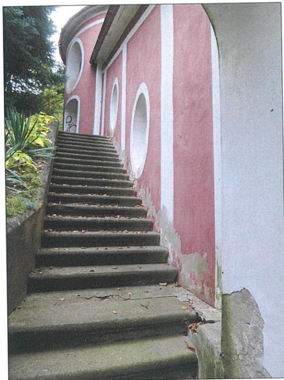
Prešov, Kaplnka Svätých schodov
