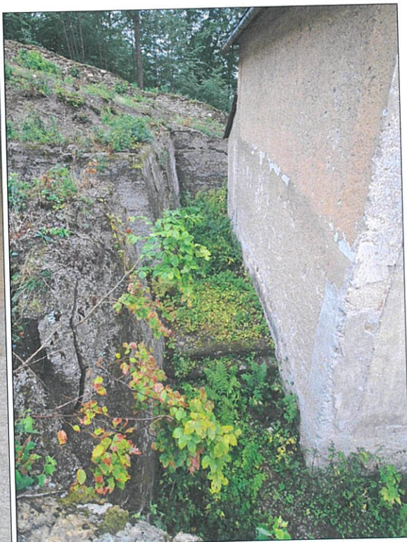
30. Oporný múr za SV fasádou kostola, v jeho strede schodisko ku Kaplnke Božieho hrobu
