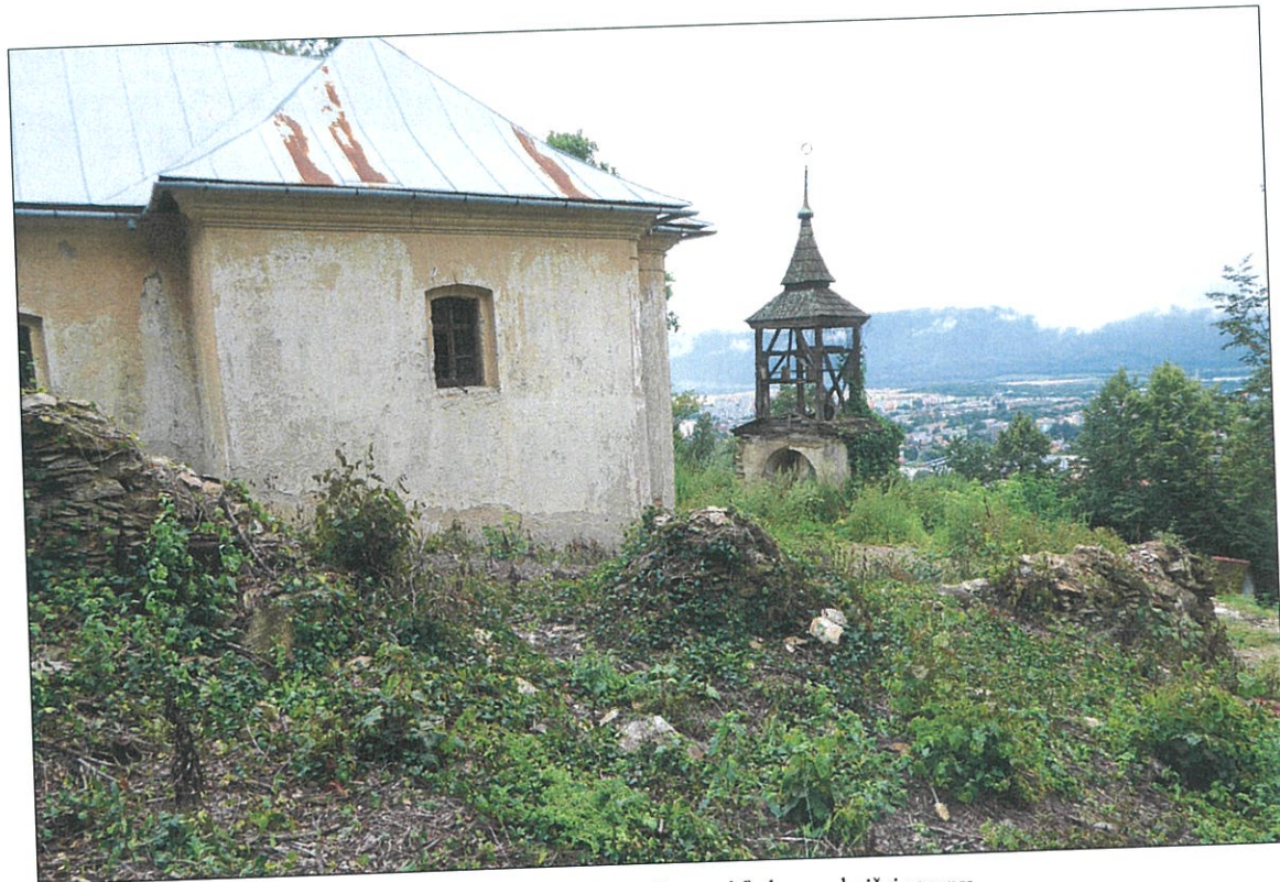
22. JZ strana ohradného múra, pohľad z vonkajšej strany
