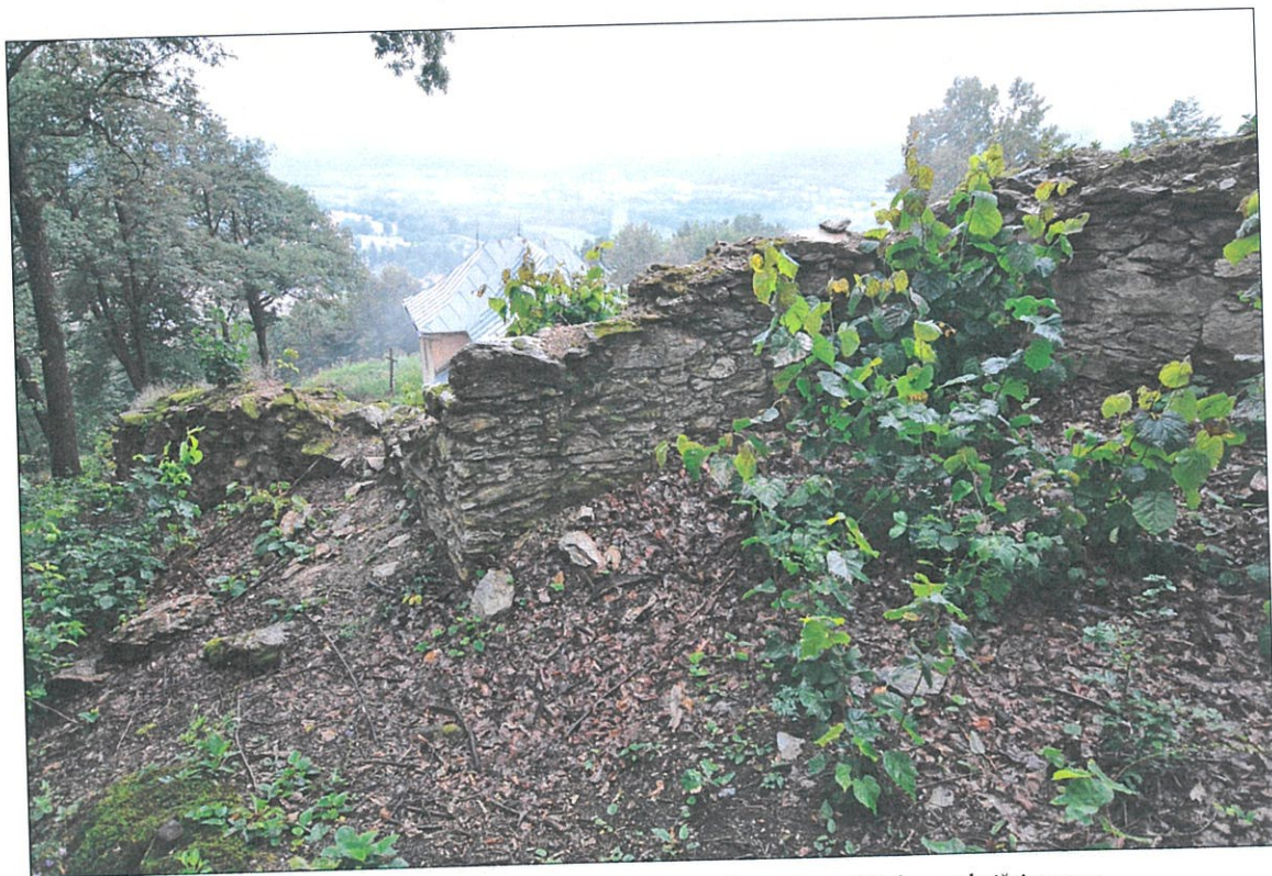
11. Ohradný múr na východnej strane v časti zalomenia, pohľad z vonkajšej strany
