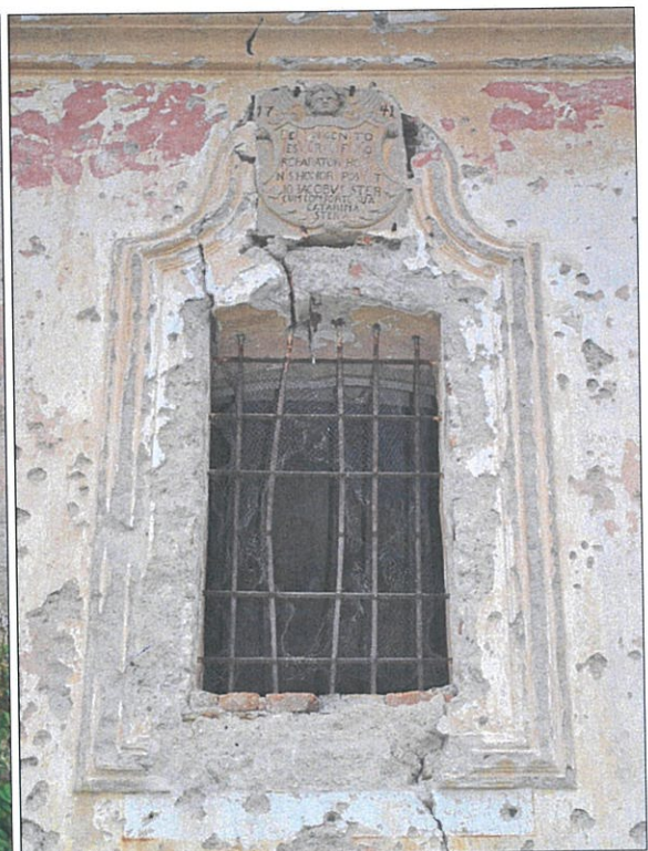
26. Okenný otvor nad vstupom do kostola na hlavnej fasáde
