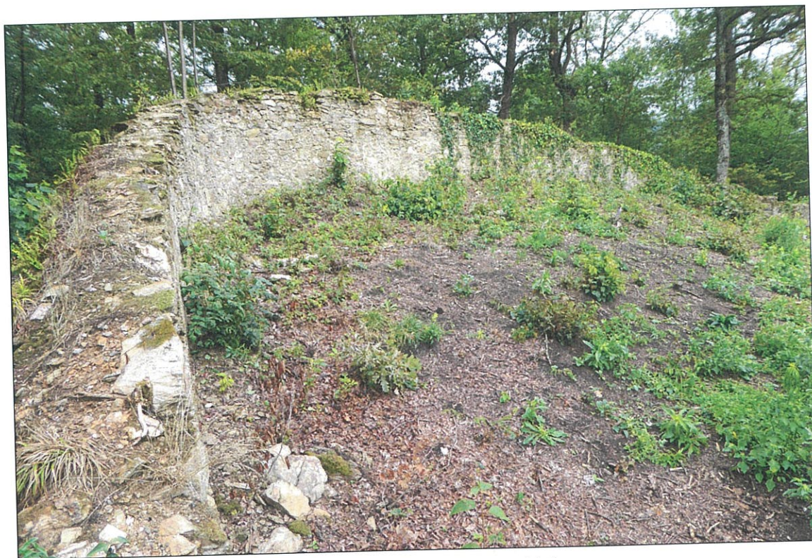
14. Severná a SV strana ohradného múra, pohľad zo severu
