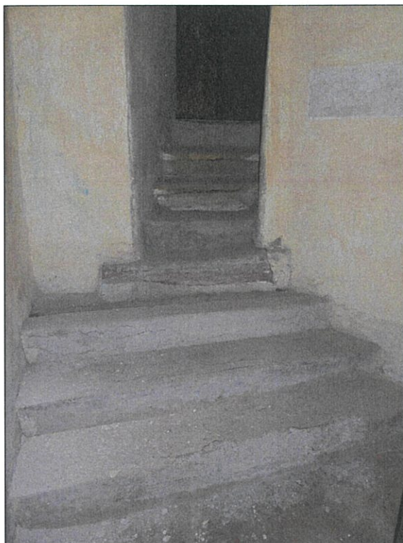
52. Sakristia, schodisko na kazateľnicu
