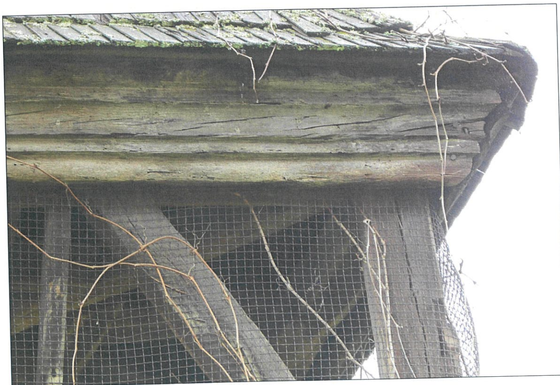
72. Zvonica, rímsa strechy
