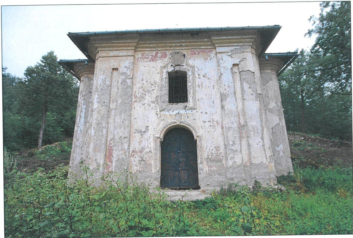
24. Hlavná – JZ fasáda kostola
