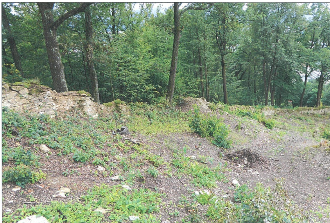
9. Ohradný múr na východnej strane
