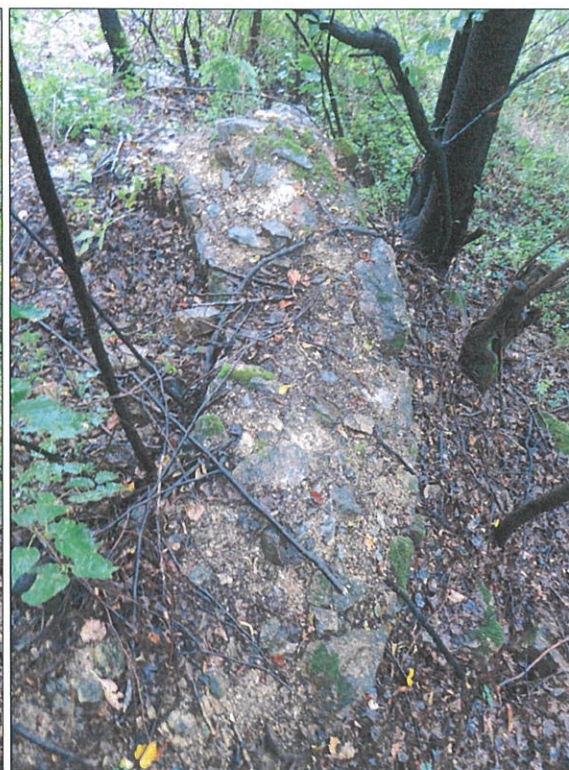
75. Torzo pôvodnej barokovej kaplnky
