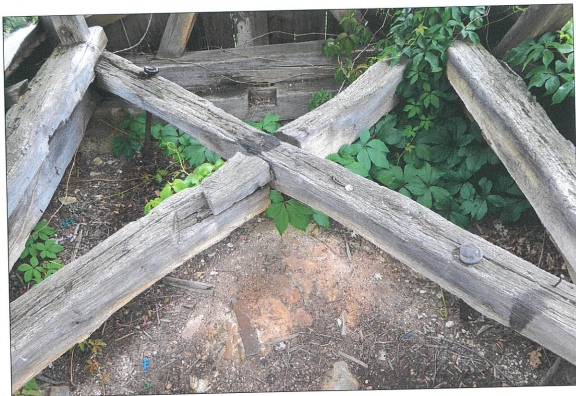
71. Zvonica, rošt zvonovej stolice
