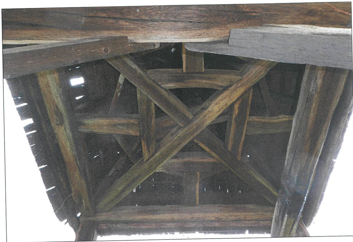
68. Zvonica, rošt krovovej konštrukcie strechy
