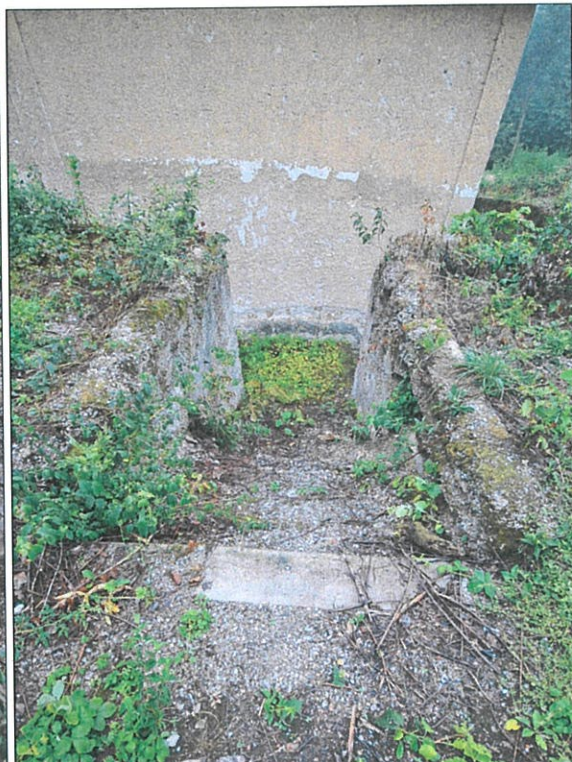
32. Schodisko od kostola ku Kaplnke Božieho hrobu
